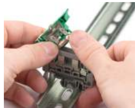
3. Установите предохранитель
