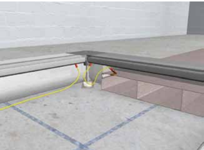
Проверка заземления в UDH...
