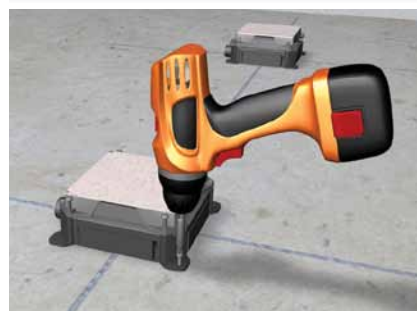
Закрепите монтажные коробки
