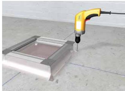
Крепление коробок UDB... или UDS3
