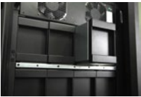
Дополнительные батарейные модули, поддерживающие горячую замену
