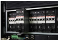
Дополнительный модуль распределения электропитания (RPDC) стоечного монтажа с модулями управления и модулями коммутационных аппаратов, поддерживающими горячую замену
