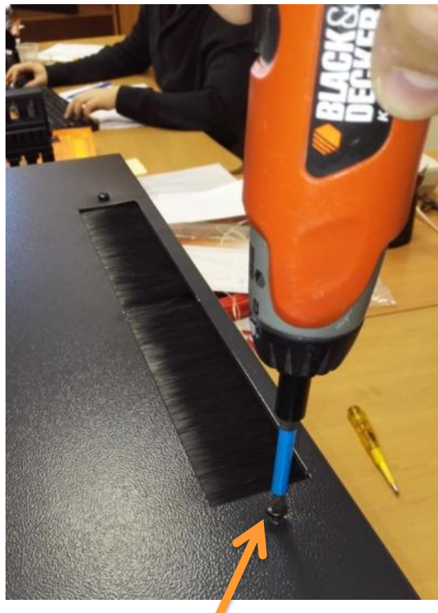
Устанавливаем щеточный ввод на 2 самореза
