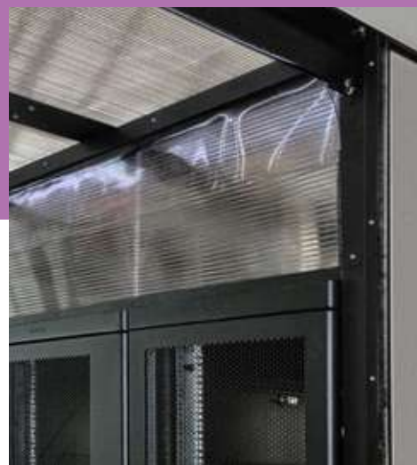
панели могут обрезаться по месту до требуемого размера
