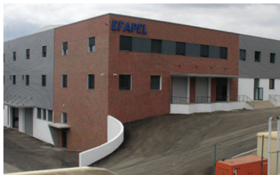
Производственное здание №3 в г. Серпинс
